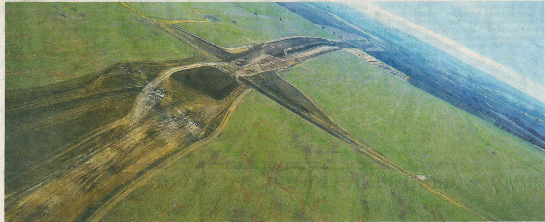
KOMPLIKACE. Skrývku ornice, kterou stavebníci provádějí už od podzimu, v těchto dnech komplikuje deštivé počasí. Nyní se řeší, jak dostat ornici ze stavby. Foto: Deník/Jiří Kopáč
