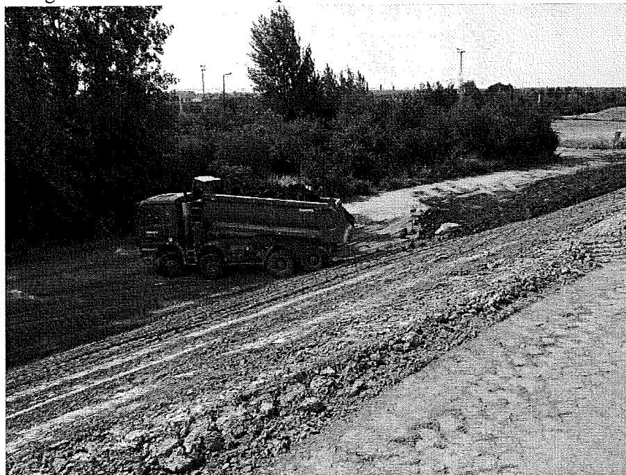
Fotografie č. 2: Ohumusování protihlukového valu na úseku SO 101.2
