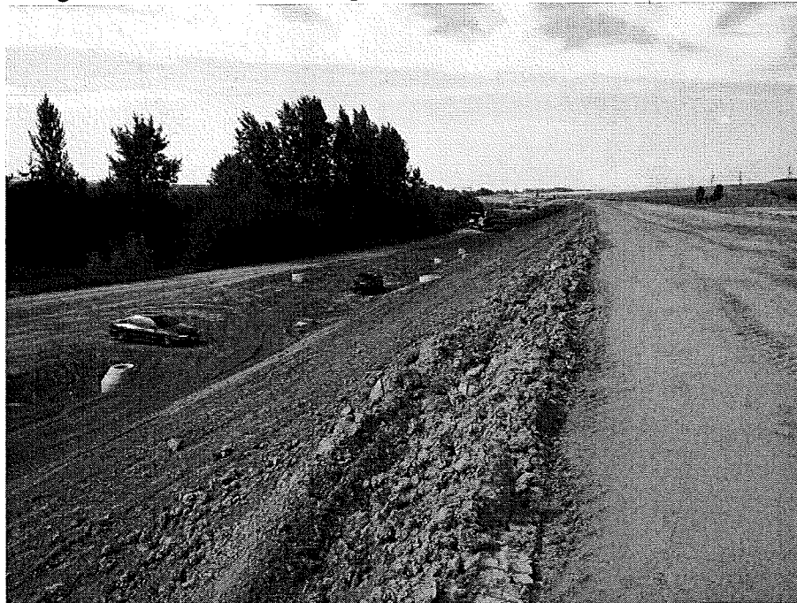
Fotografie č. 1: Ohumusování protihlukového valu na úseku SO 101.2
