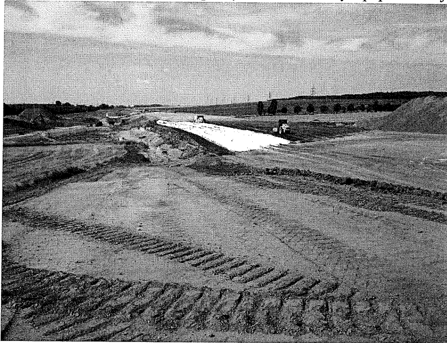
Fotografie č. 3: Frézování závápněných vrstev zeminy a popelovin a jejich hutnění válcem
