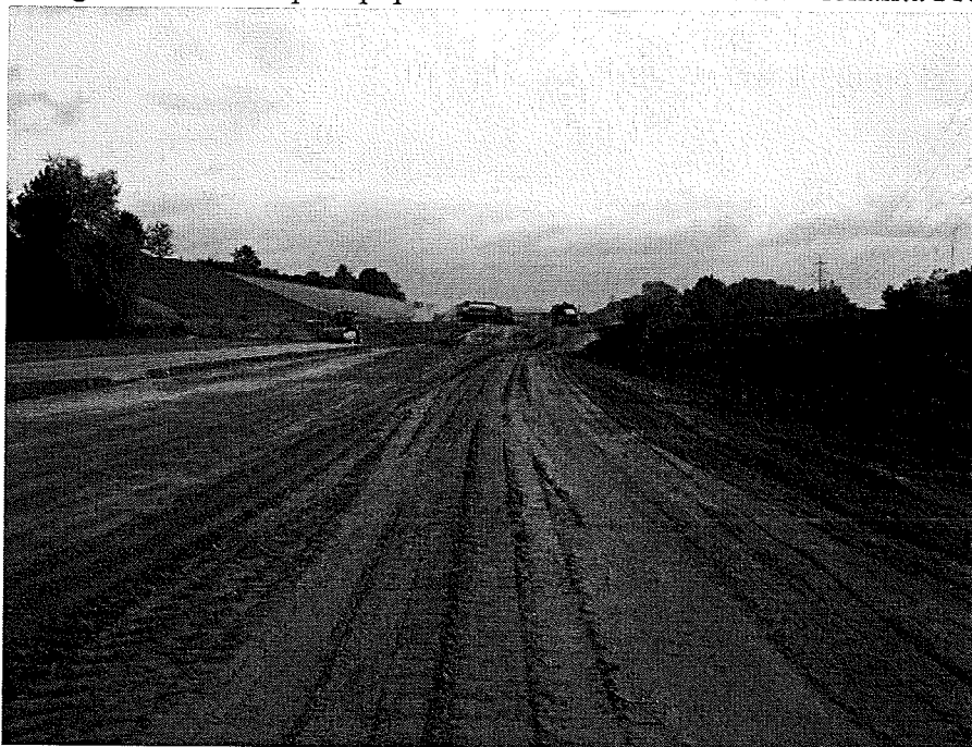
Fotografie č. 4: Skrápění popeloviště na úseku SO 101.2 – lokalita Prosenice
